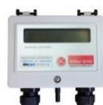
**Controllo velocità ventilatori a prevalenza costante:** regolando la velocità del ventilatore di mandata, permette di mantenere la prevalenza di mandata costante, al variare della prevalenza richiesta, solo con ventilatori EC Plug fan. **Costant static pressure fan speed control:** it maintains a constant static pressure by adjusting the supply fan speed, when varying the setting static pressure, only with EC Plug fan.
